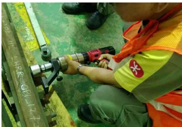
RMW-26用于地铁轨道螺栓拆装
